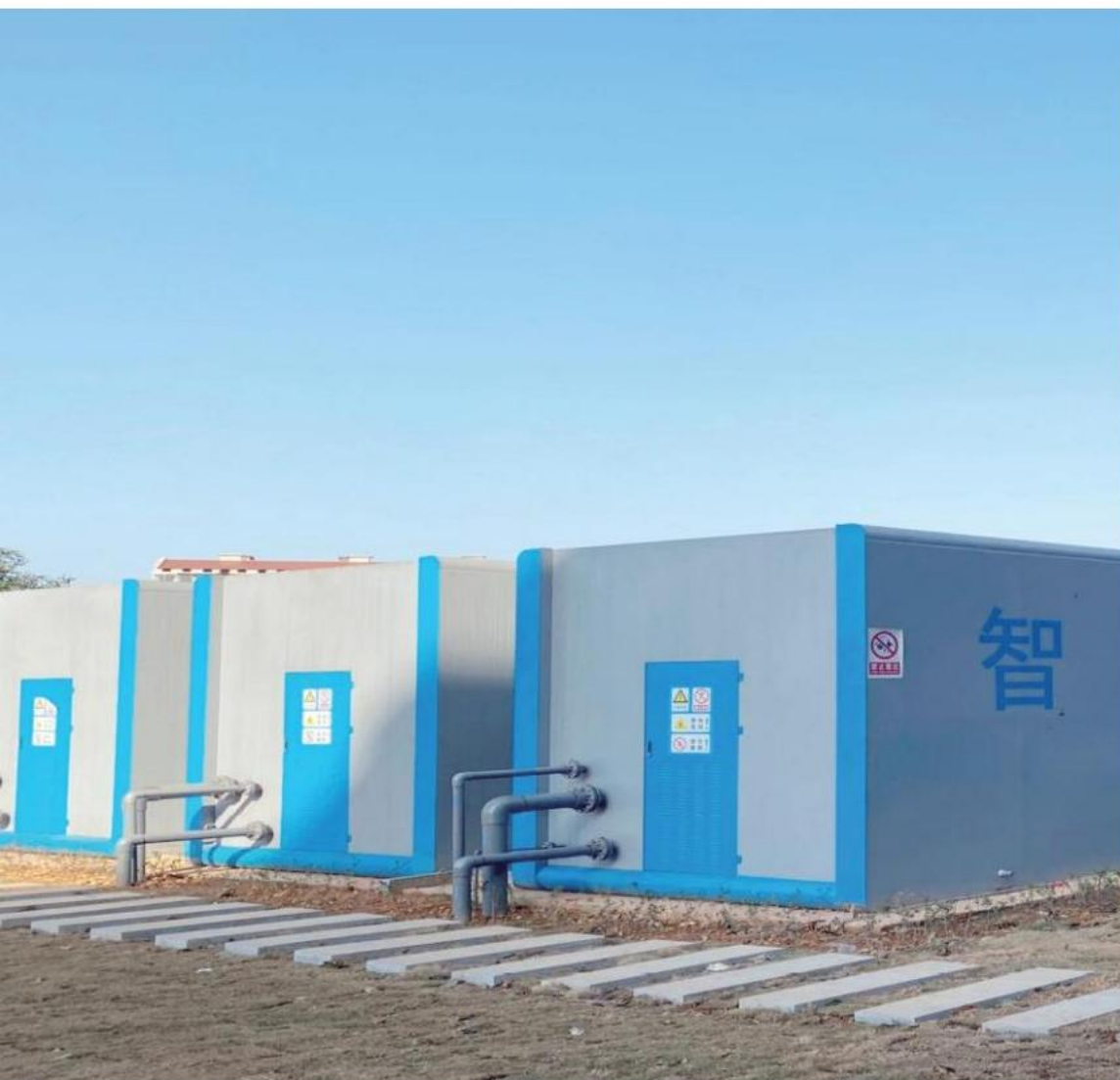
湖南省衡南县乡镇污水处理设施建设项目
